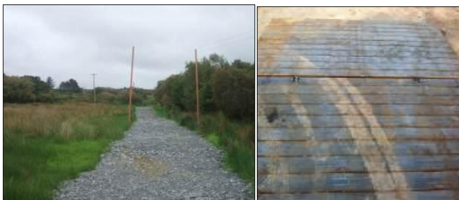
Fíor 7.5: Bóthar Sealadach Cloiche agus Trasnáin Adhmaid
